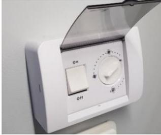
Kühler auf Stufe 4 stellen, bei sehr heisser Witterung Stufe 6-7.
