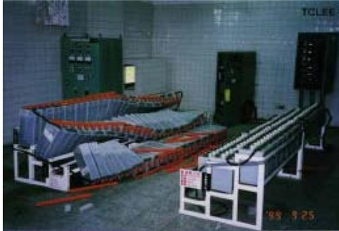
*Bild E.3: Folgen fehlender Absturzsicherung: Abgestürzte Batterien im Unterwerk Chungliao nach dem Chi-Chi-Beben in Taiwan, 1999 (Foto: ASCE-TCLEE).
