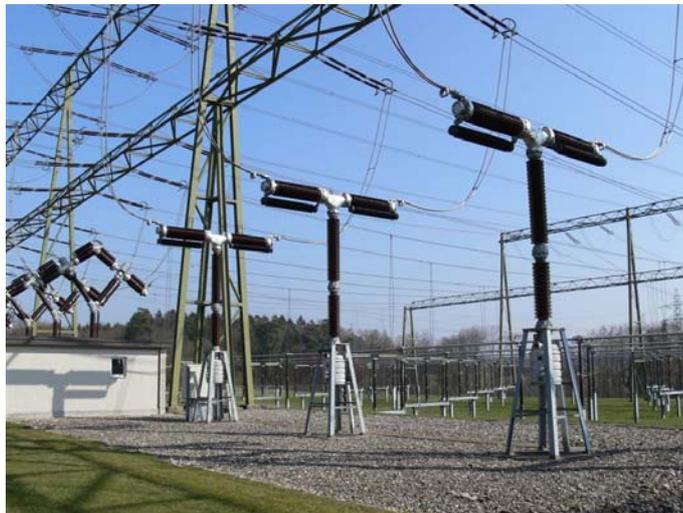
*Bild 2: 380 kV-Leistungsschalter, die über im Wesentlichen vertikale Leiterseile mit den Nachbar-Apparaten verbunden sind: Diese Konfiguration lässt grosse Erdbebenverschiebungen zu, ohne dass die Leiterseile straff werden.*
