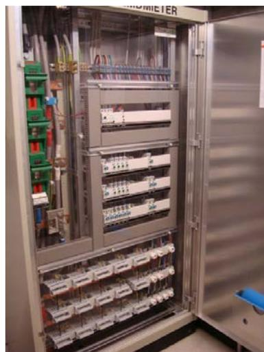
**Bild 1: Energie-Schaltgerätekombination für die Bedienung durch instruierte Personen**
